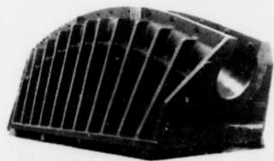
Dernière des quatre selles des tours principales des câbles du nouveau pont de Québec, livrée par Marine Industrie Limitée. Ces selles en acier coulé pèsent 27 tonnes et mesurent 20 pieds de long par 8 pieds de large par 8 pieds de haut.
