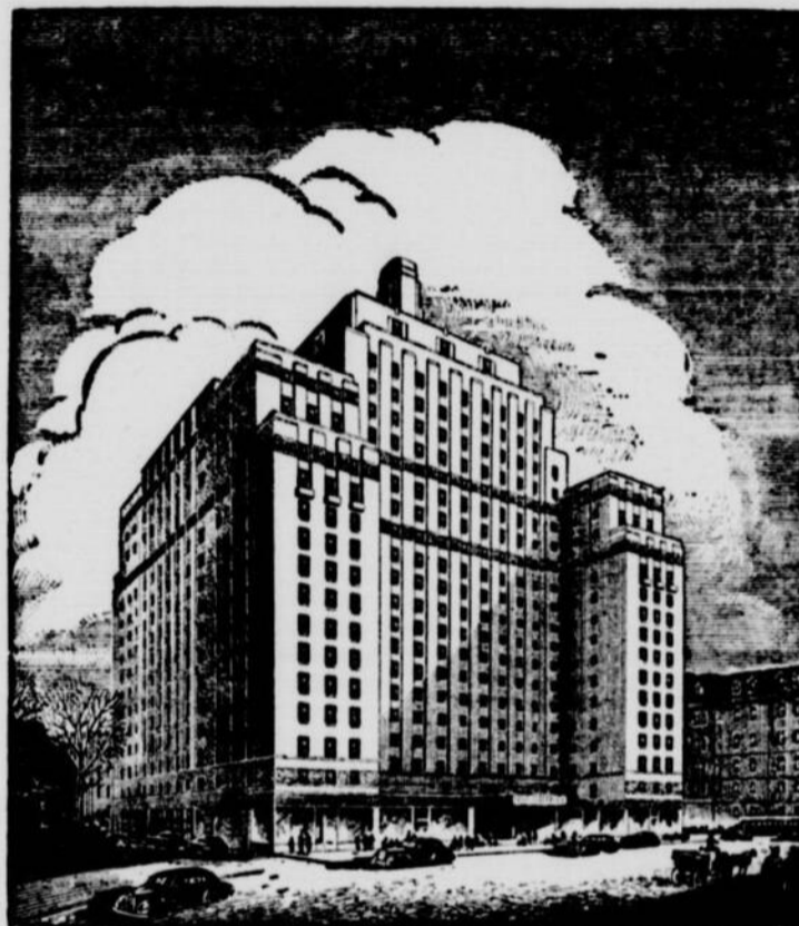
Le nouvel hôtel LAURENTIAN de 1.100 chambres, en construction à Montréal; ouvrira ses portes au début de l'an prochain.
