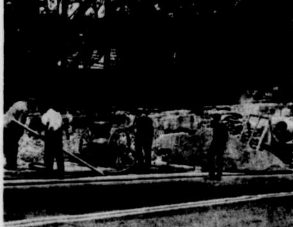
LES TRAVAUX SE POURSUIVENT. — Depuis quelques semaines, les employés de la cité ont entrepris des travaux de réfection, rue des Grandes-Fourches. On répare le mur longeant les rivières Magog et St-François. (Photo La Tribune, par Studio Breton)
