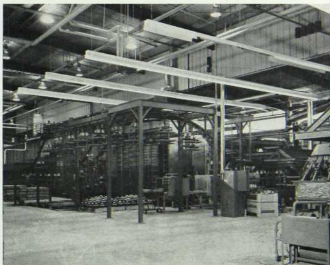
Une partie de l'intérieur de l'usine.
