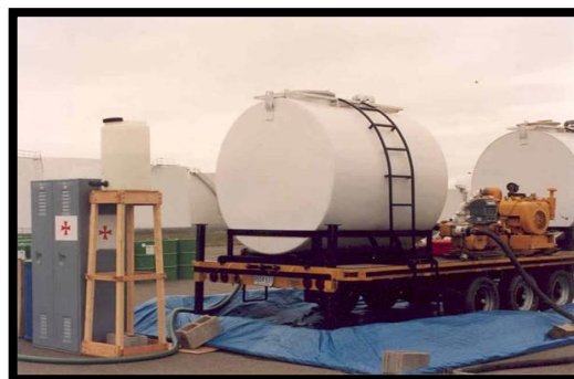
Figure 2.1 Citerne mobile dans un aménagement de rétention
