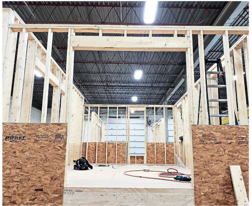
Une unité en construction dans l'usine de Trois-Rivières. (Photo courtoisie)
