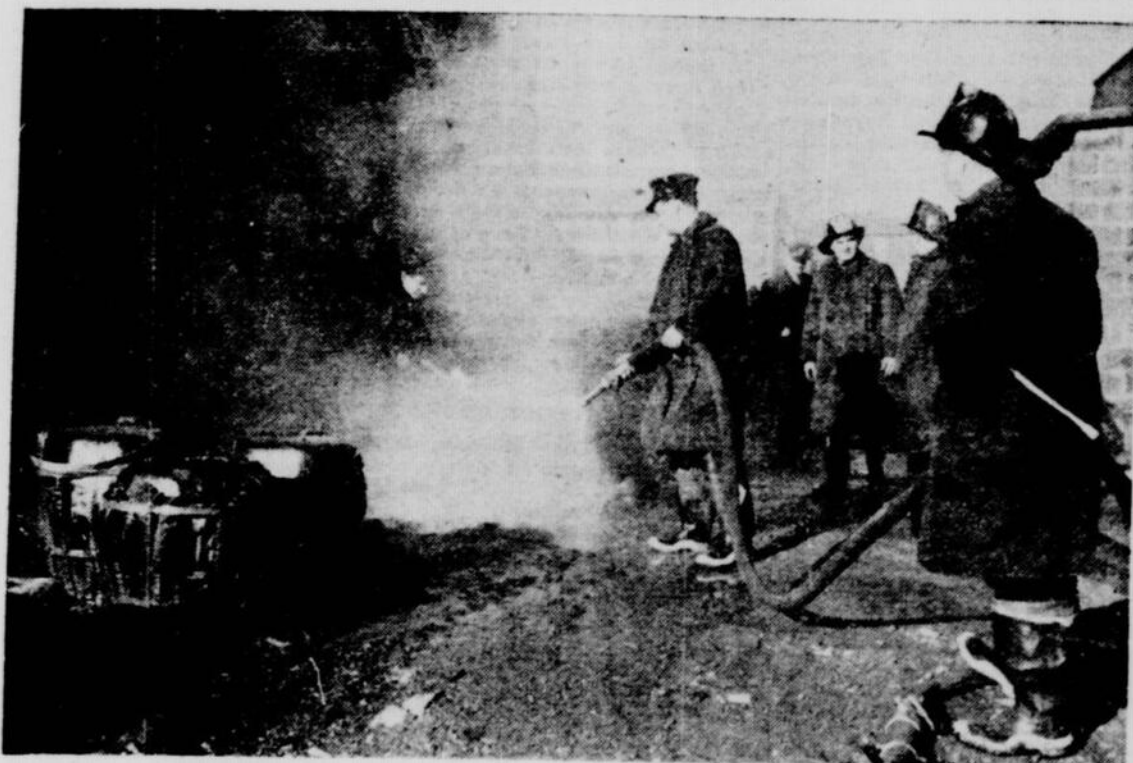
Les pompiers de la division nord furent alertés, hier après-midi, mais pour peu de temps, dans la cour attenante au Collège Notre-Dame, dans le quartier Ahuntsic. Une équipe d'ouvriers était à y réparer la toiture d'une bâtisse quand, soudain, un réservoir à goudron prit feu, répandant un épais nuage de fumée acre. Il ne fallut que quelques minutes aux membres de la brigade pour éteindre les flammes. On les voit ici à l'œuvre.
