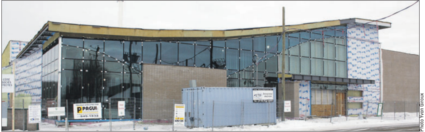
Les ouvriers ont pu compléter la coquille avant l'hiver et travaillent maintenant à l'intérieur du bâtiment.
