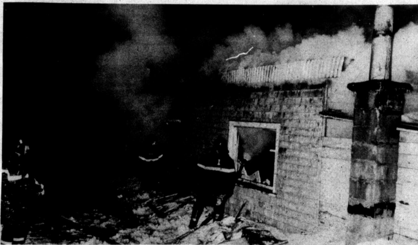
On évalue à quelques 50 000 $ les dommages causés à la bâtisse et à environ 25 000 $ les pertes en matériel.
