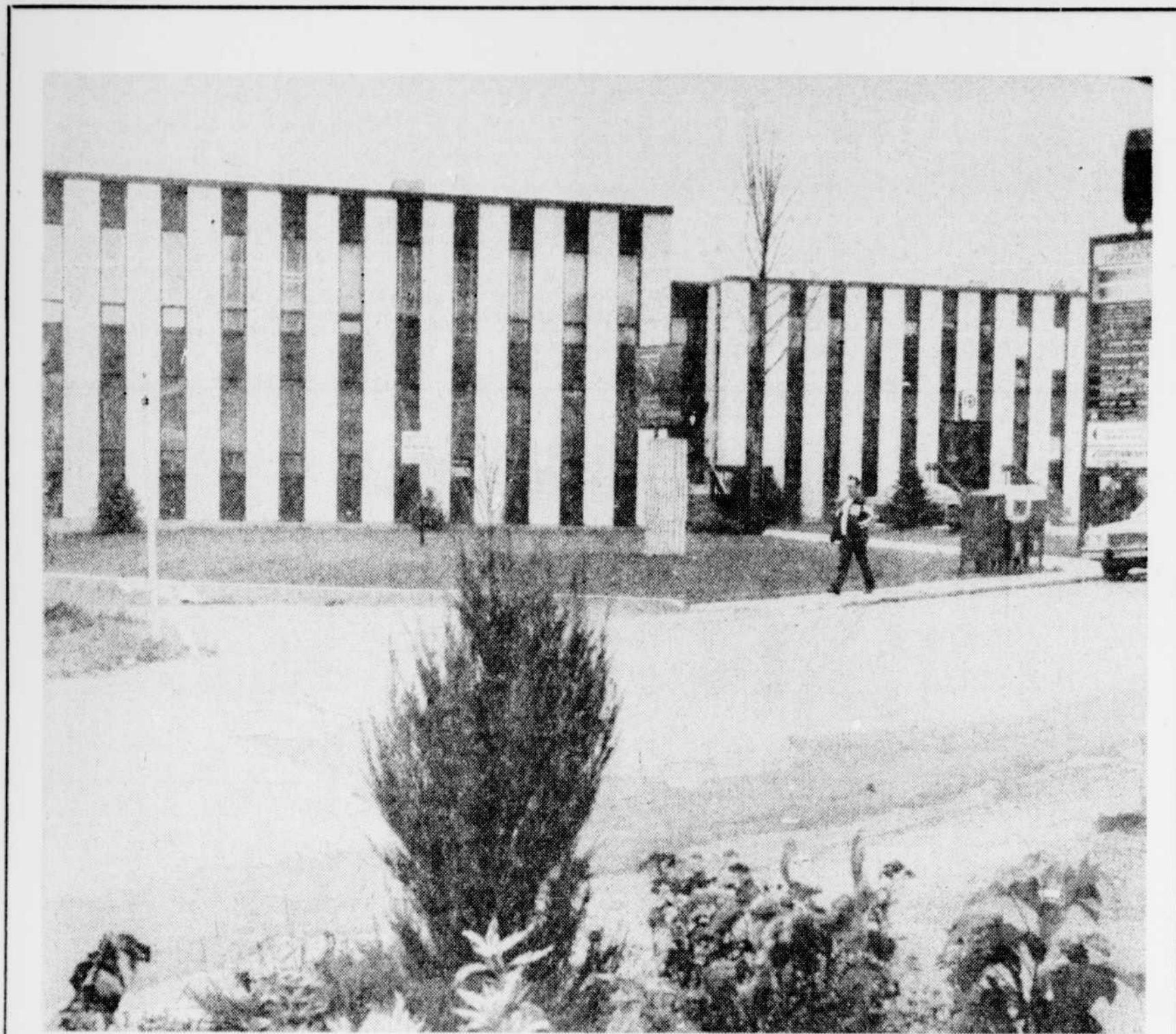
Le gros édifice du 113 de la rue Saint-Georges, à Lévis, où logent des bureaux de plusieurs ministères du gouvernement du Québec.
