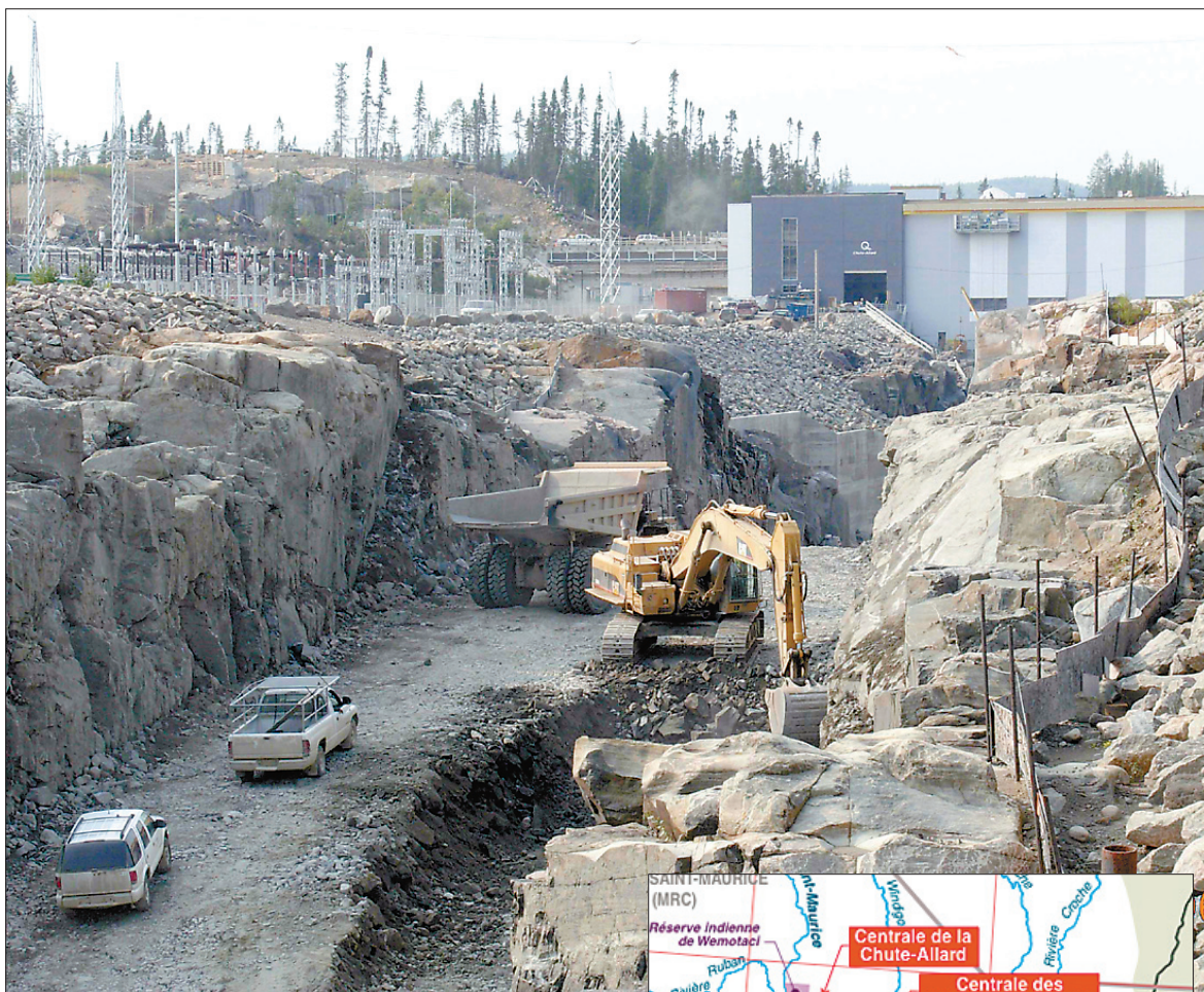
Dans le cas de la Chute-Allard, on terminera l'année en complétant le bétonnage des ouvrages de retenues.
