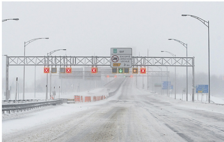
Les automobilistes qui souhaitaient traverser le pont Lavolette ont dû suivre une patrouille de retenue, alors que deux voies sur quatre étaient fermées, dimanche avant-midi. — PHOTO: STÉPHAN DESROCHERS
