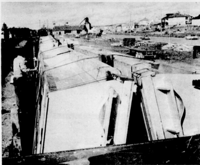
POUR LE BARRAGE DE TEMISCAMINGUE photo du haut: pièce en chargement photo du bas: wagon prêt pour l'expédition chargé de pièces lourdes, pour le barrage (1ère chute) comté de Témiscamingue
