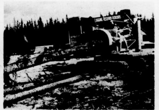
Arbomatik - Machine qui ébranche, écorce et coupe l'arbre en 8 pièces.
