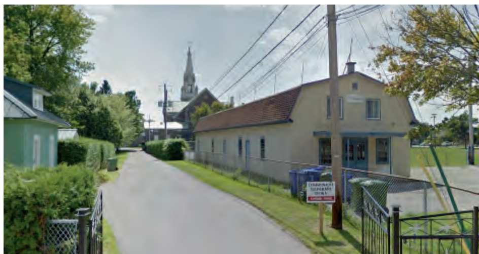
C'est cette salle que l'on souhaite démolir pour en construire une autre.
