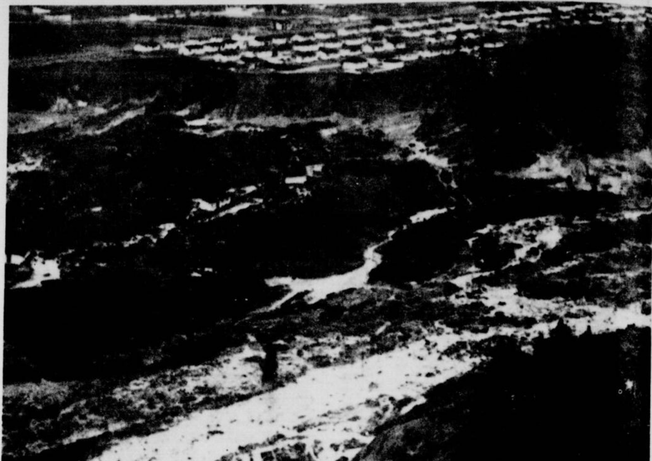
40 maisons se sont englouties dans cette fosse immense. A l'arrière plan, on aperçoit une partie de ce qui reste du village de Saint-Jean-Vianney. (Photo PC)
