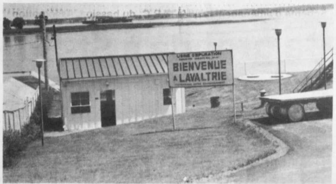
L'usine d'épuration de Lavaltrie (photo d'archives...) a besoin d'un agrandissement pour suffir à la demande.
