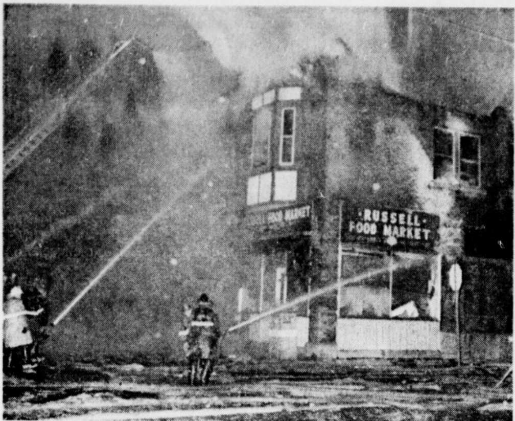
(Photo Champlain Marci) DEUX COMMERCES ET QUATRE LOGIS DETRUITS PAR LES FLAMMES — Deux établissements commerciaux et quatre logements ont été détruits par un incendie qui a ravagé un édifice situé à l'angle de la rue Somerset et de l'avenue Russell, hier soir, dans la capitale. Le sinistre qui a fait rage pendant plus de quatre heures a causé des dégâts estimés à plus de $100,000. Personne n'a été blessé.
