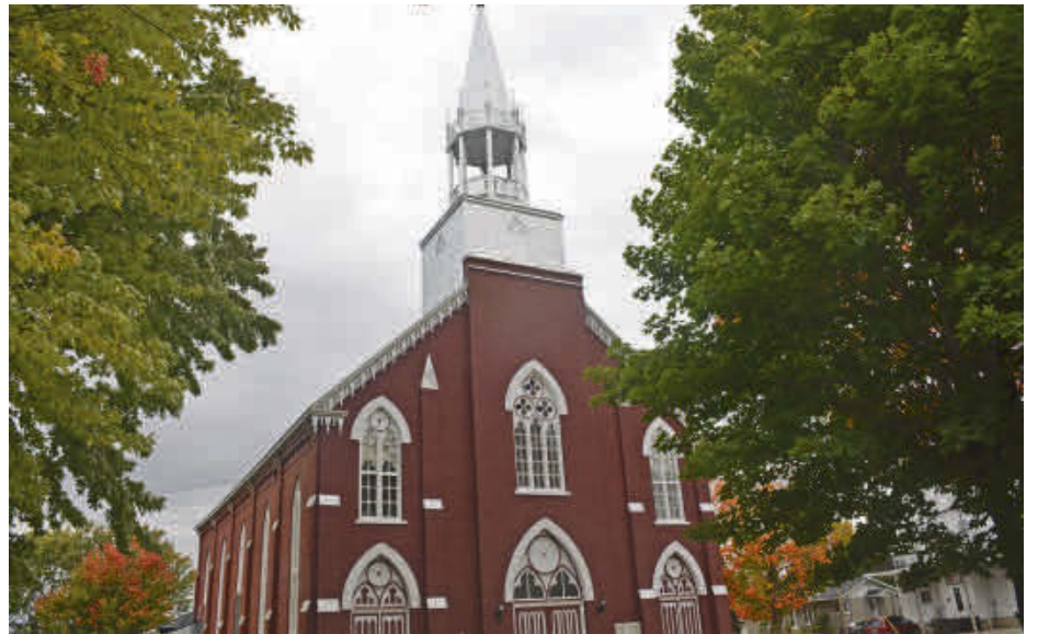
L'église de Saint-Théodore d'Acton a récemment fait l'objet de rénovations pour son clocher. Des travaux seront effectués sur la toiture au printemps 2017.
