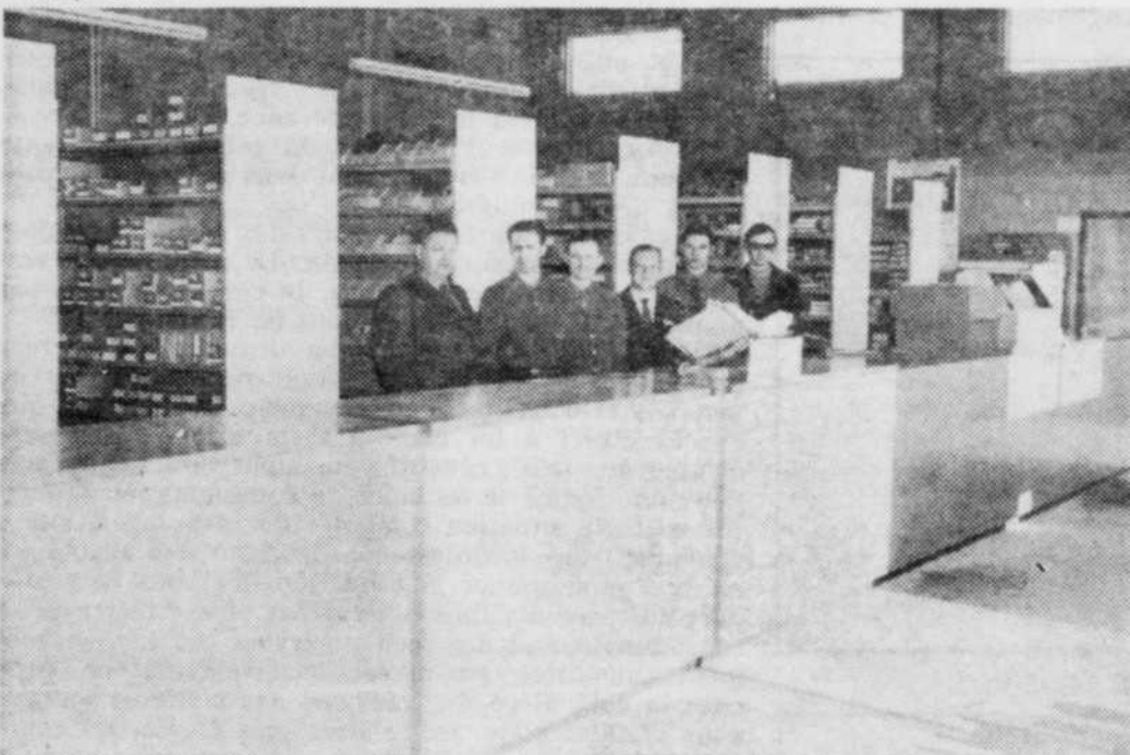
Voici l'aspect intérieur que présentent les nouveaux locaux de l'entreprise.
