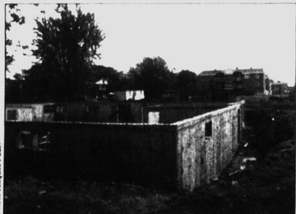
Le chantier est en marche depuis quelques semaines.
