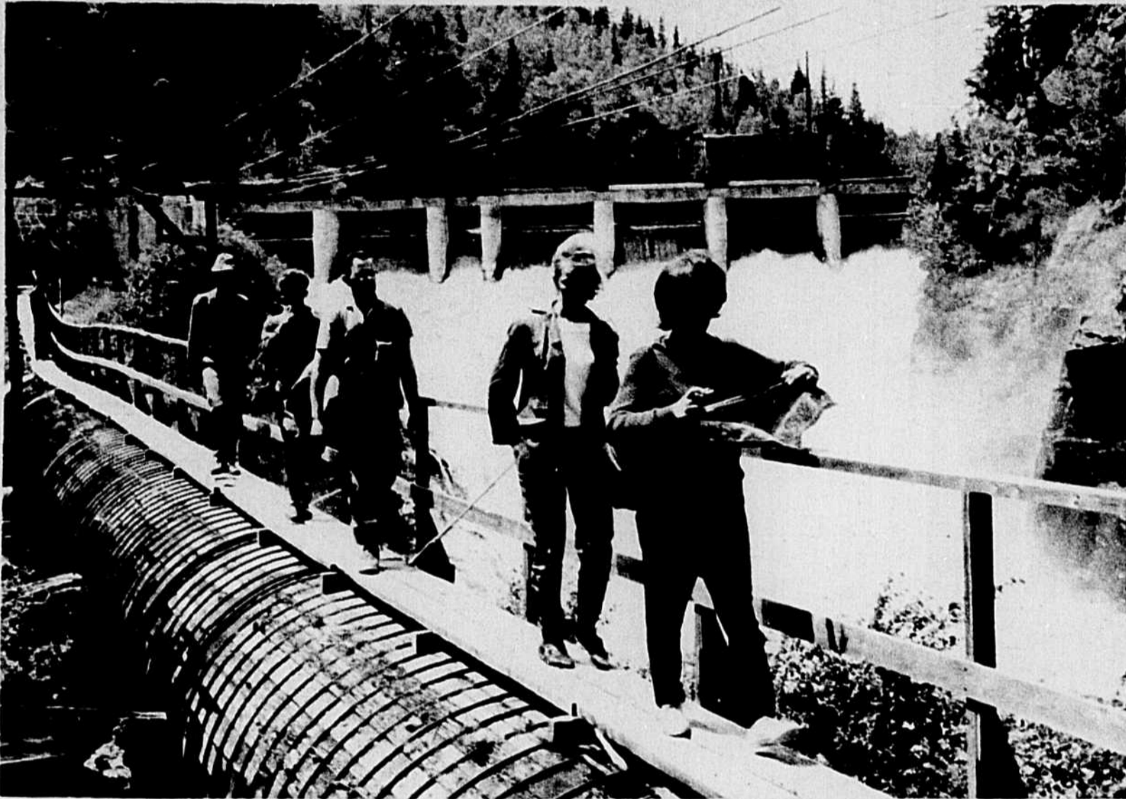
Un groupe d'étudiants passent sur un tuyau près du barrage qui alimente un pouvoir hydraulique.
