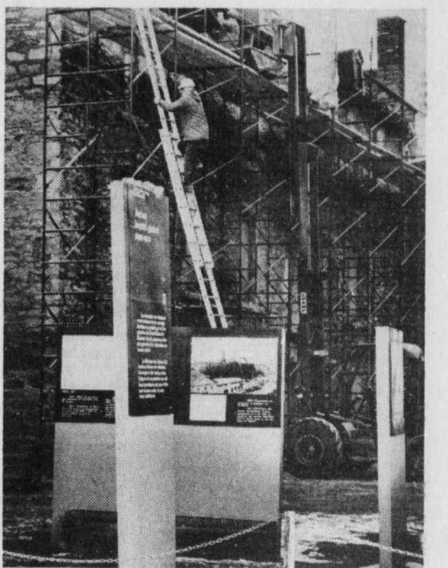
Des ouvriers ont entrepris récemment les travaux de restauration de l'ancien hôpital général des Soeurs Grises, dans le Vieux-Montréal.
