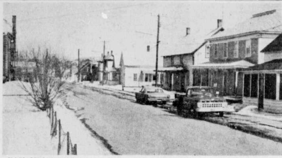
ELLES SERONT DEMOLIES — Cette photo donne une idée du secteur de la rue St-Pierre, à Coaticook, dont la Commission scolaire de l'endroit se portera acquéreur, d'ici quelque temps afin d'agrandir les terrains de la commission et de construire une nouvelle école primaire, pour remplacer l'école Sacré-Coeur, dont on voit une partie, à gauche de la photo. (Photo Ross, Coaticook)
