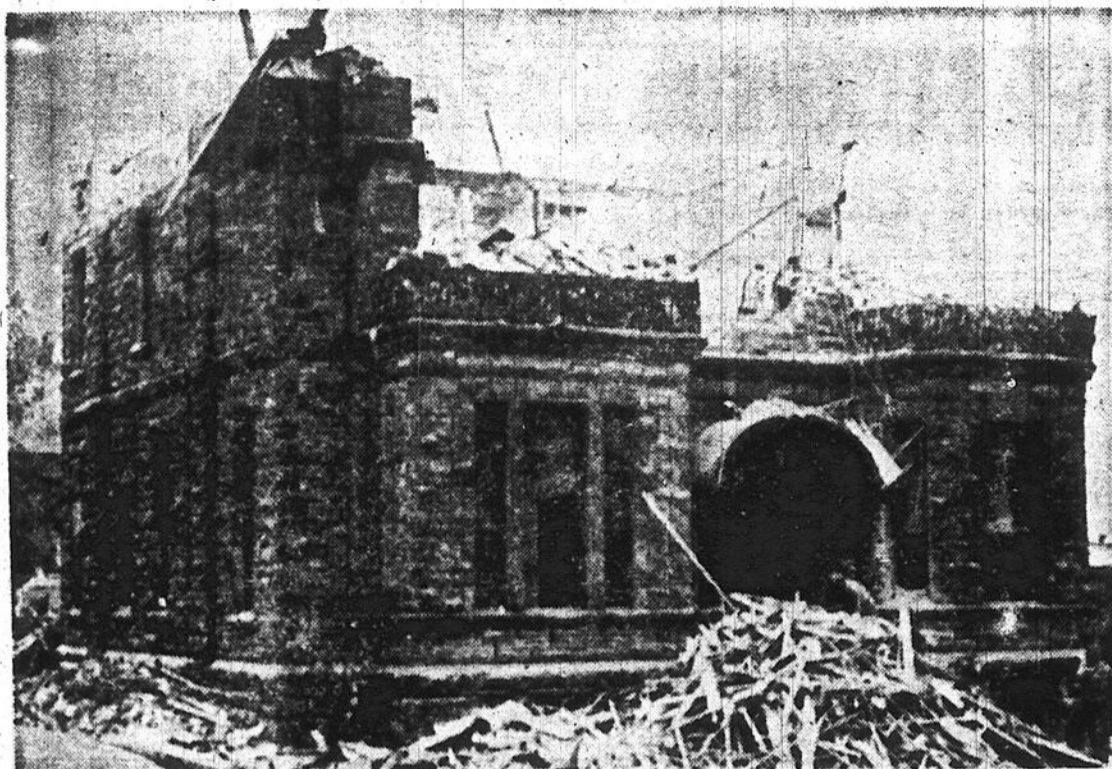
Au 3453, rue Drummond, on continue quand même de démolir cette maison. (Photo "Montréal-Matin", par Bernard Lauzé)
