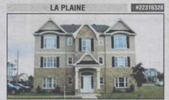
LA PLAINE #22318328 2 cdc, 1 salle de bains. Secteur paisible près de tous les services. Plafond cathédrale, foyer au gaz. À voir!! 167 900$
