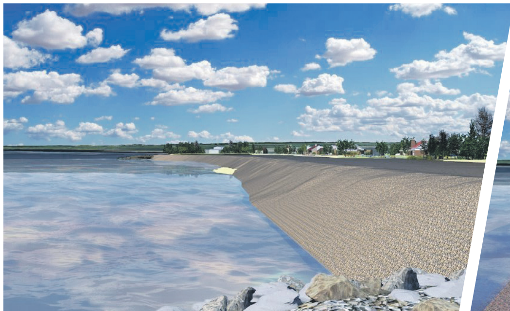
Profil de la plage Rochelois juste après les travaux Image courtoisie
