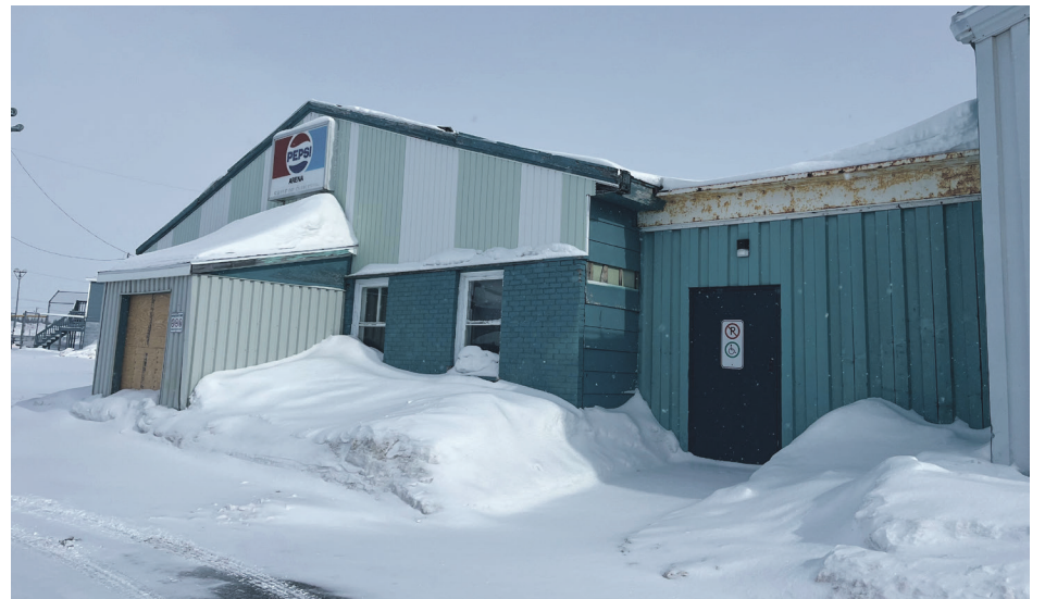
La salle communautaire de l'aréna Denis-Perron qui sera détruite prochainement. Photo Olivier Ménard-Logier
