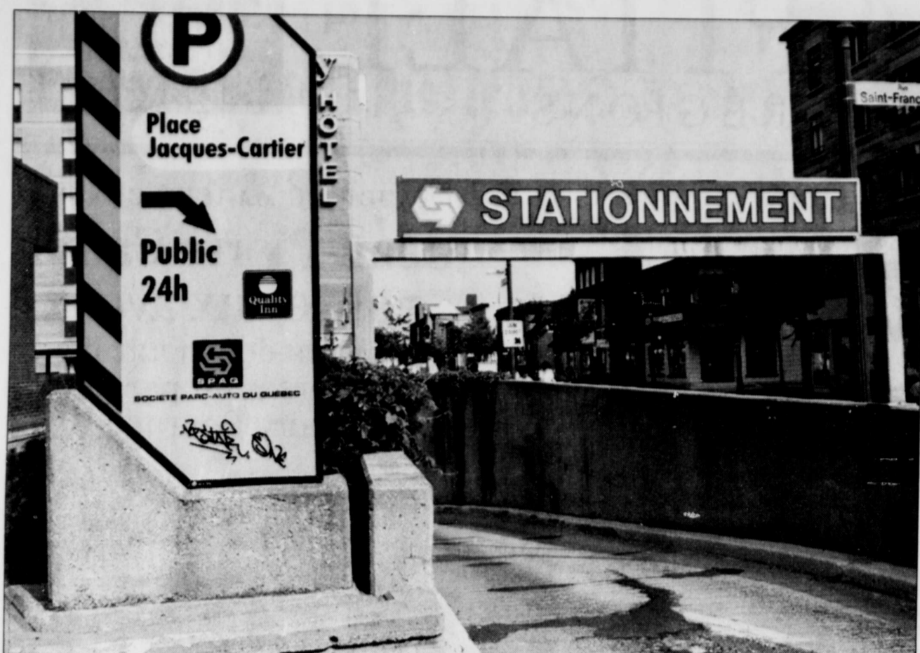
Sous la bibliothèque Gabrielle-Roy, la plupart des espaces ne sont plus utilisables. Le béton risque de s'effondrer. Des piliers de métal soutiennent la structure.
