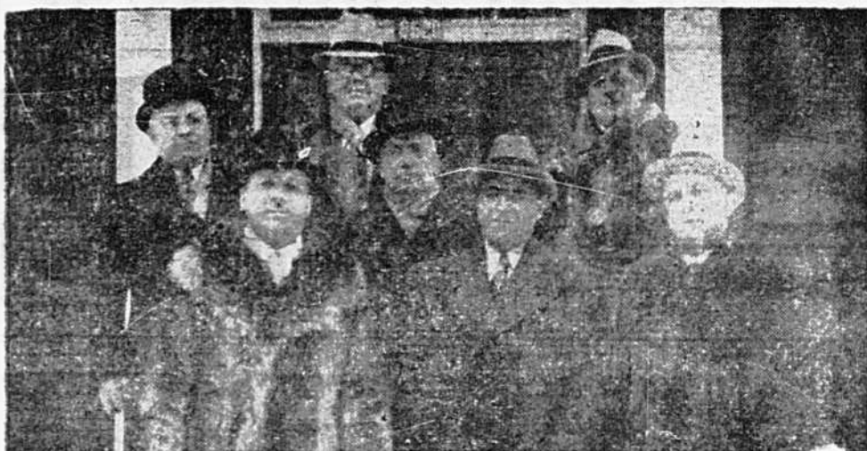
Hier avait lieu l'inauguration officielle des travaux de construction de l'égout collecteur Henri-Julien. Après la cérémonie il y eut réception à la demeure de l'échevin Henri Jarry. Plusieurs échevins et autres invités qui n'apparaissent pas ici assistaient aussi à la cérémonie. On remarque première rangée de gauche à droite: MM. Adhémar Raynault, maire de Montréal; Henri Jarry, échevin du quartier Villieray; Ovide Taillefer, président du comité exécutif. Deuxième rangée, de gauche à droite: MM. L.-O. Jalbert agissant comme président de la commission des égouts; Abraham Dupéré, échevin de Mercier; A.-E. Goyette, leader du conseil; Omer Barrière, échevin d'Achutes.
