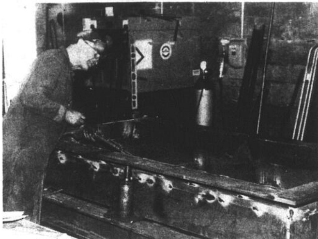
Une porte de voûte est assemblée par un spécialiste de la soudure.
