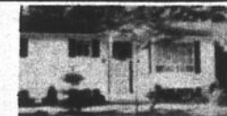
41 Des Merisiers, Victo Sous-sol fini
