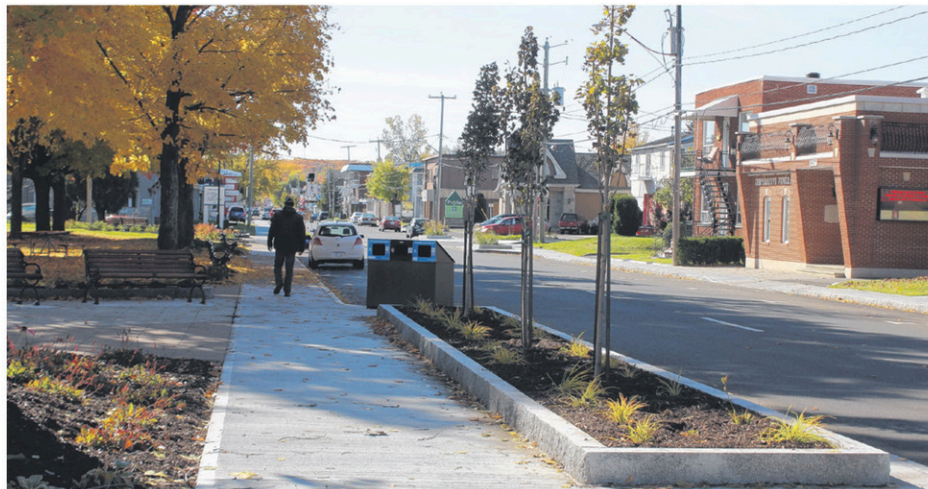
Les conduites les plus âgées avaient été installées en 1921. (Photo TC Media - Myriam Lortie)
