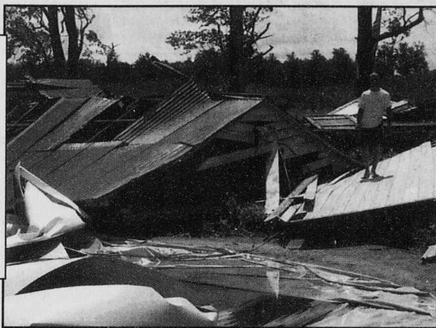
La propriété de Daniel Clément du Canton d'Eaton a sérieusement été endommagée par la tempête dans la nuit de dimanche à lundi. Sur la photo, Louis Réhel montre les dégâts causés au garage et à la piscine qui ont littéralement été soufflés par la tempête.
