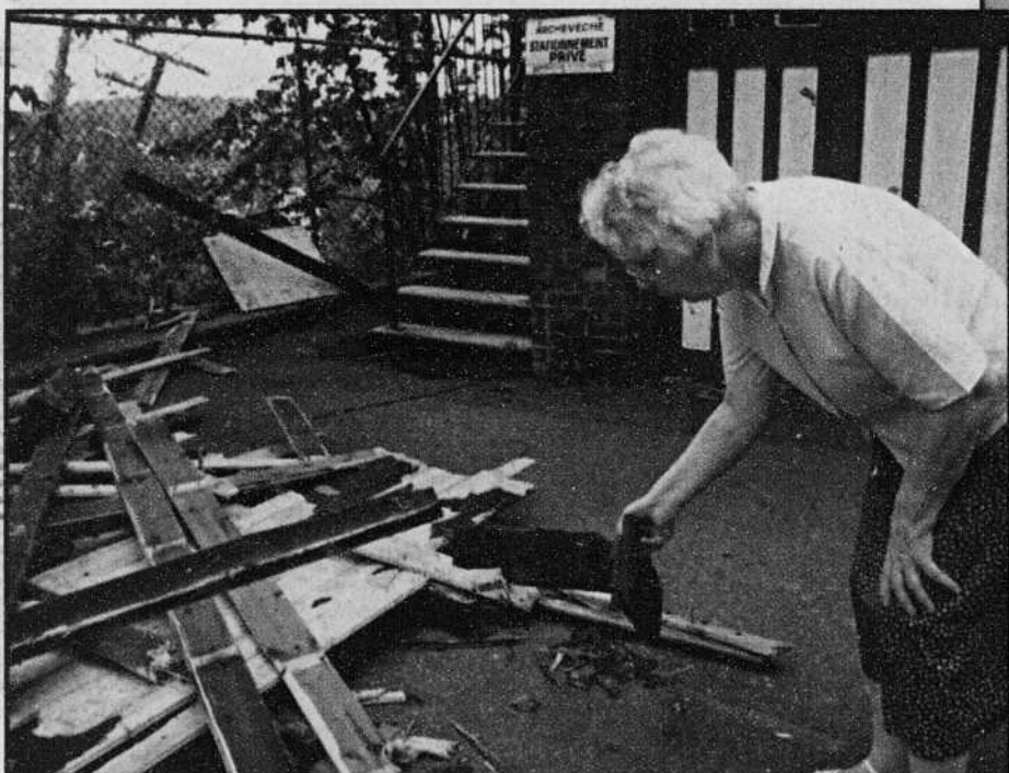
Rues du Palais et de l'Académie, Mme Blanche Langlois n'en revenait pas de la violence des vents. Elle examine ici une partie de la toiture de l'immeuble où elle réside.
