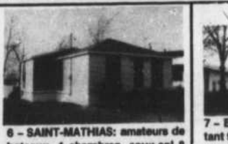
6 - SAINT-MATHIAS: amateurs de bateaux, 4 chambres, sous-sol 8 pieds, bord de l'eau direct. XAVIER ABÉLÉ, 464-0500.
