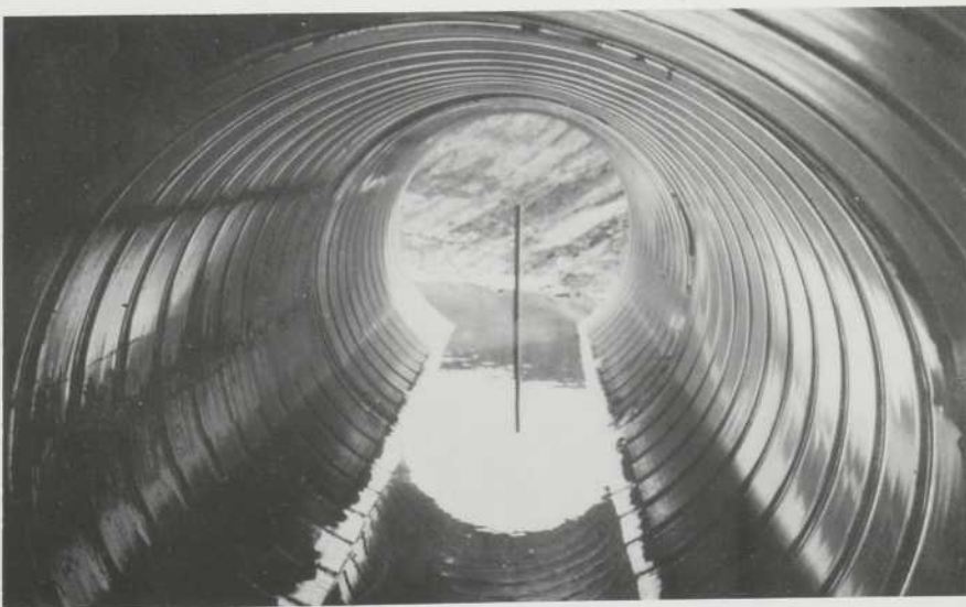
Une tôle d'acier lisse, uniquement marquée par les joints agrafés, constitue une surface laissant l'eau s'écouler librement.
