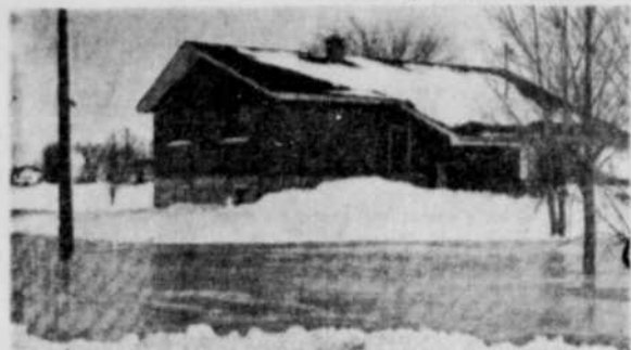
INONDATION. — La police a porté secours à 30 membres de sept familles qui se trouvaient emprisonnées dans leurs demeures depuis plus de 24 heures à Repentigny, à la suite d'une crue des eaux du St-Laurent. Plusieurs pieds d'eau recouvraient la route conduisant à leurs foyers.
