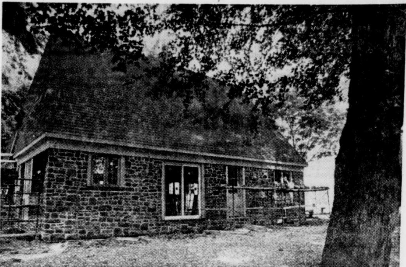
Vue arrière de la maison familiale Kinsmen à Expo-Québec, une valeur de $115,000 avec l'ameublement et la décoration. Qui sera le chanceux? Le Soleil, André Boucher
