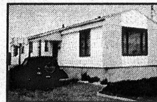
ST-ANTONIN: Rue des Pins: Maison modulaire sur solage. 4 chambres. Sous-sol aménagé. (6058)
