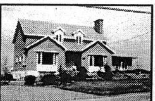
RIVIÈRE-DU-LOUP: Rue Lafontaine: Belle grande résidence de 9 1/2 pièces + local en annexe en location. Terrain de 25 000 p.c. env. Secteur commercial. Vue sur la rivière. (6045)
