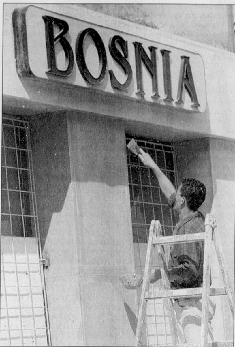
Profitant de ces jours d'accalmie à Sarajevo, un propriétaire d'hôtel du centre-ville fait quelques travaux d'entretien sur la façade de son établissement.
