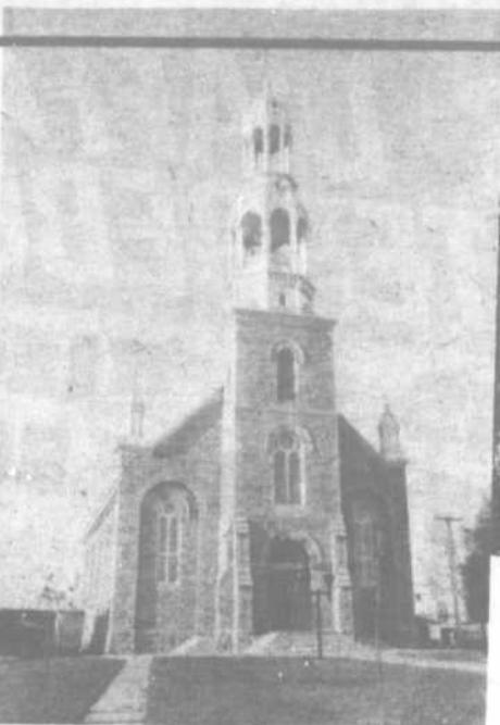
L'église centenaire de Mascouche recèle de nombreux trésors architecturaux.
