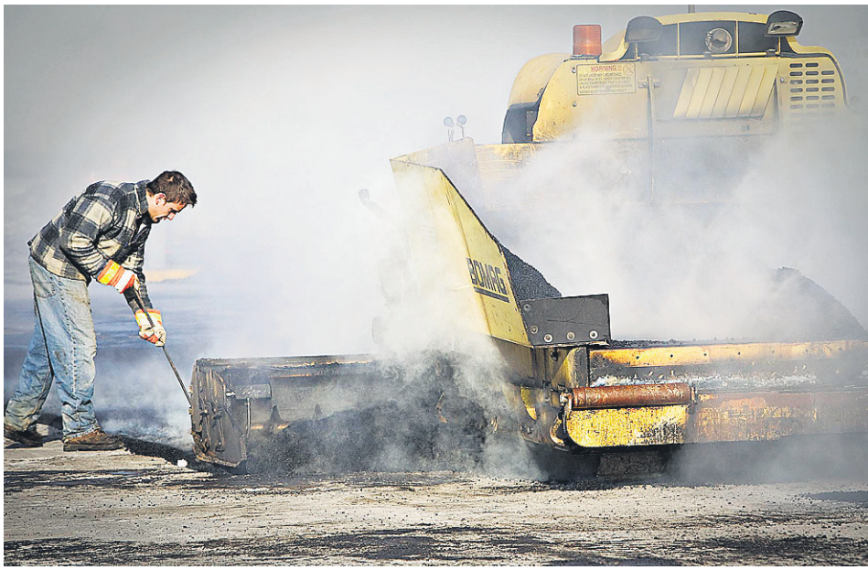
PHOTO PATRICK SANFAÇON, LA PRESSE Des travailleurs de la voirie de Longueuil ont réparé le chemin Chambly sur plus de 2 km, hier. Une opération saluée par les automobilistes, même si ceux-ci devaient faire un détour hier.
