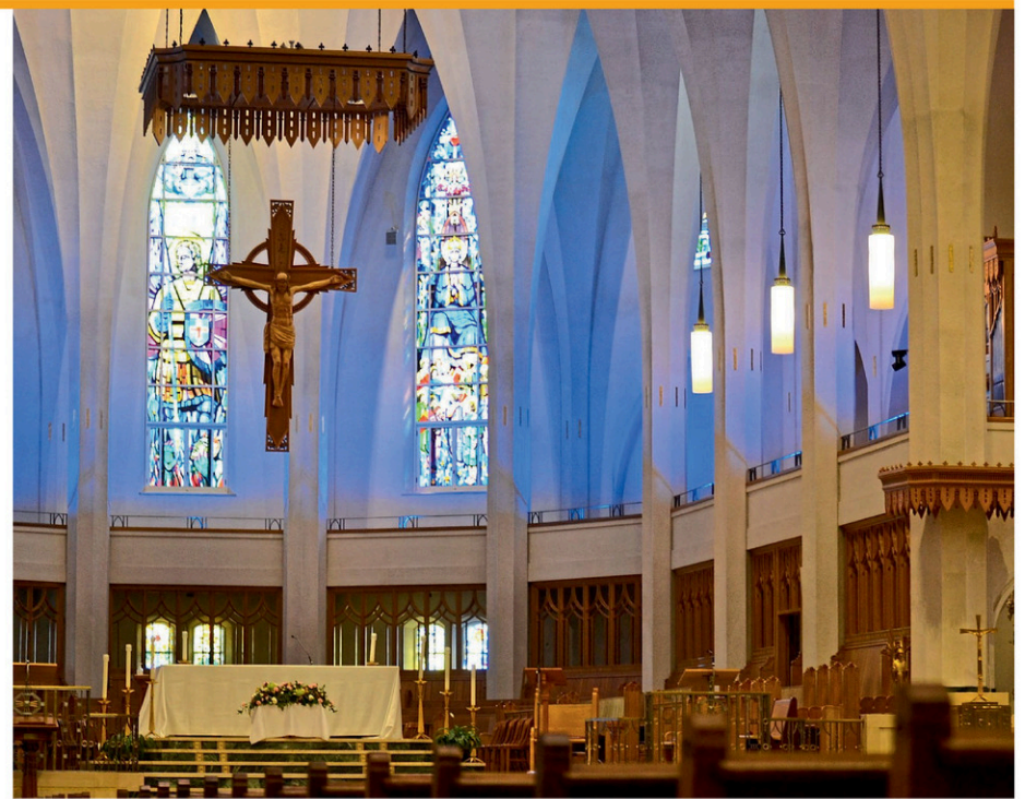
En plus des travaux de peinture, des lumières ont été ajoutées pour illuminer davantage la basilique-cathédrale Saint-Michel. (Photo Sherbrooke.info - Nickolas Bergeron)
