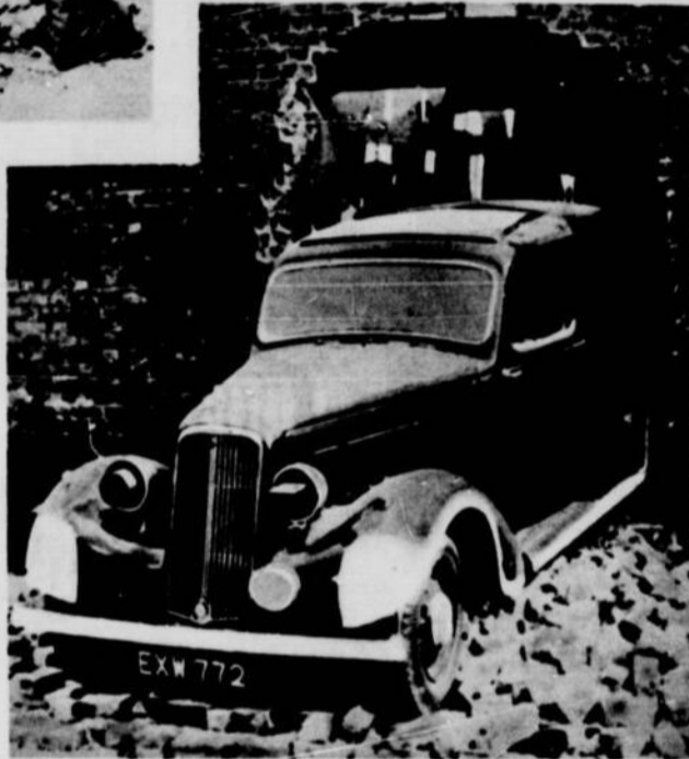
Un explosif a ouvert cette "porte" dans le mur d'un garage de la capitale
