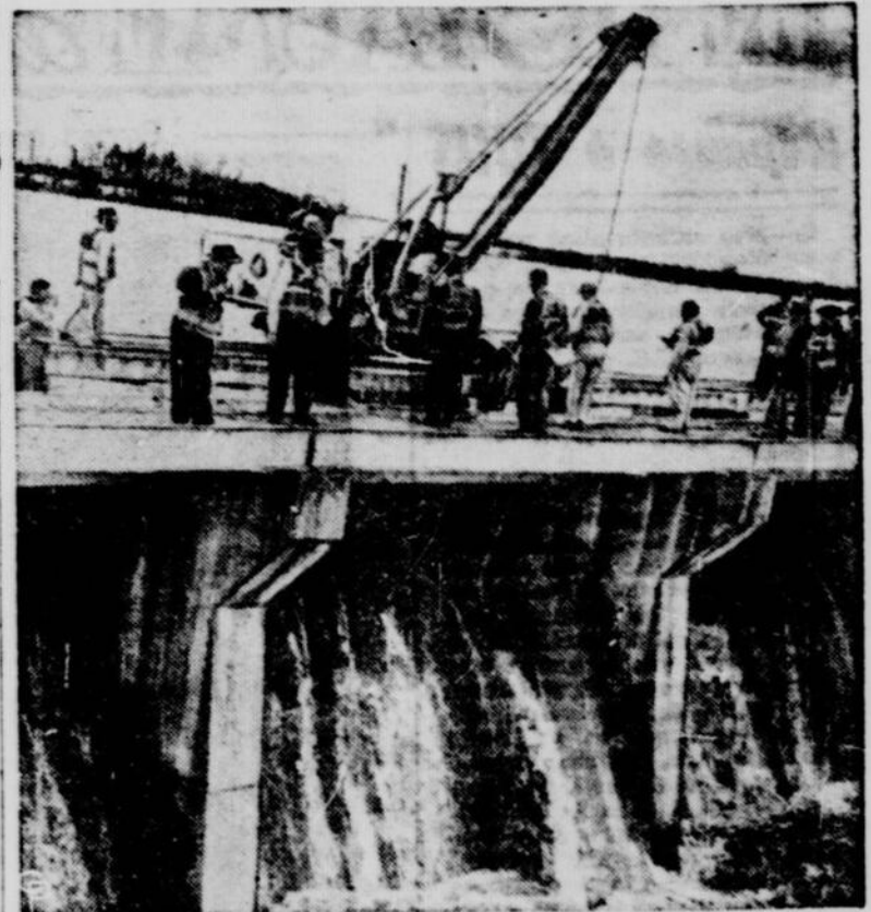
Pour écarter le danger causé par les eaux gonflées du Mississippi, à Nouvelle-Orléans, les ingénieurs américains ont ouvert la digue du Bonnet Carré, afin de détourner les eaux de la cité.
