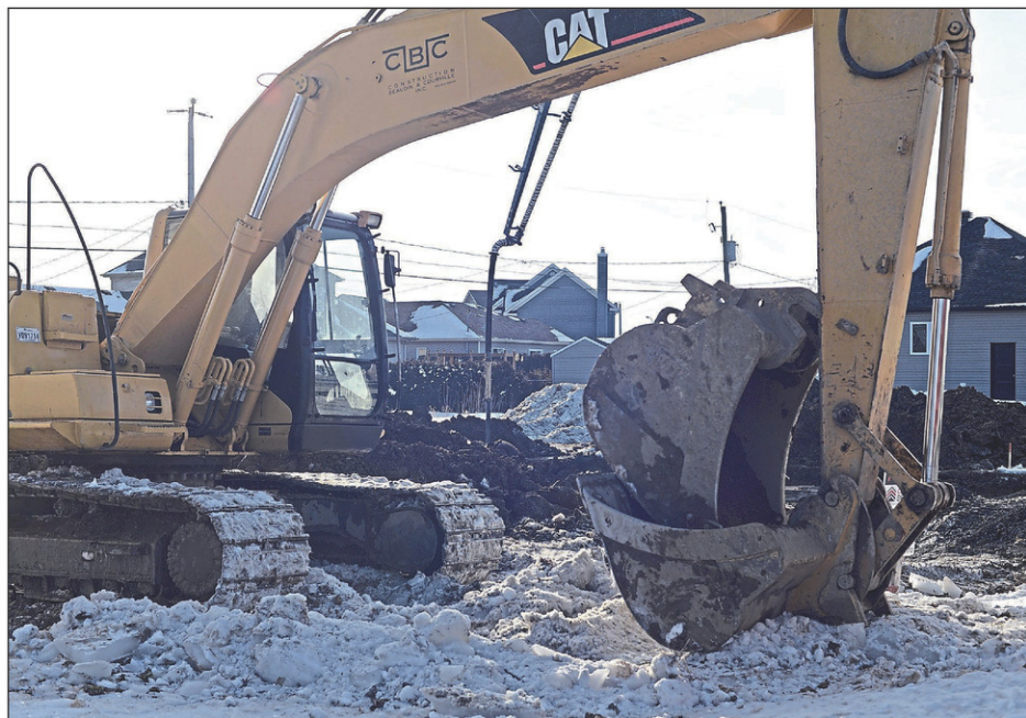
Depuis le début de l'année qui s'achève, 502 mises en chantier ont été enclenchées à Saint-Jean-sur-Richelieu.
