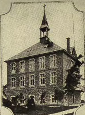
ANCIENNE ÉCOLE DETRUITE PAR UN INCENDIE
