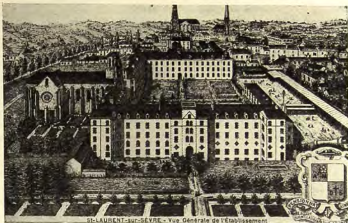
ST-LAURENT-sur-SÈVRE - Vue Générale de l'Établissement
