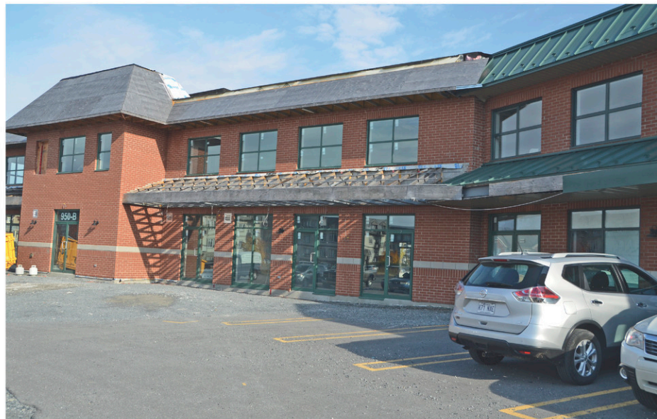
La construction du deuxième bâtiment commercial du Groupe Lobato à la gare n'est toujours pas terminée. Photo Denis Bélanger | L'Œil Régional ©
