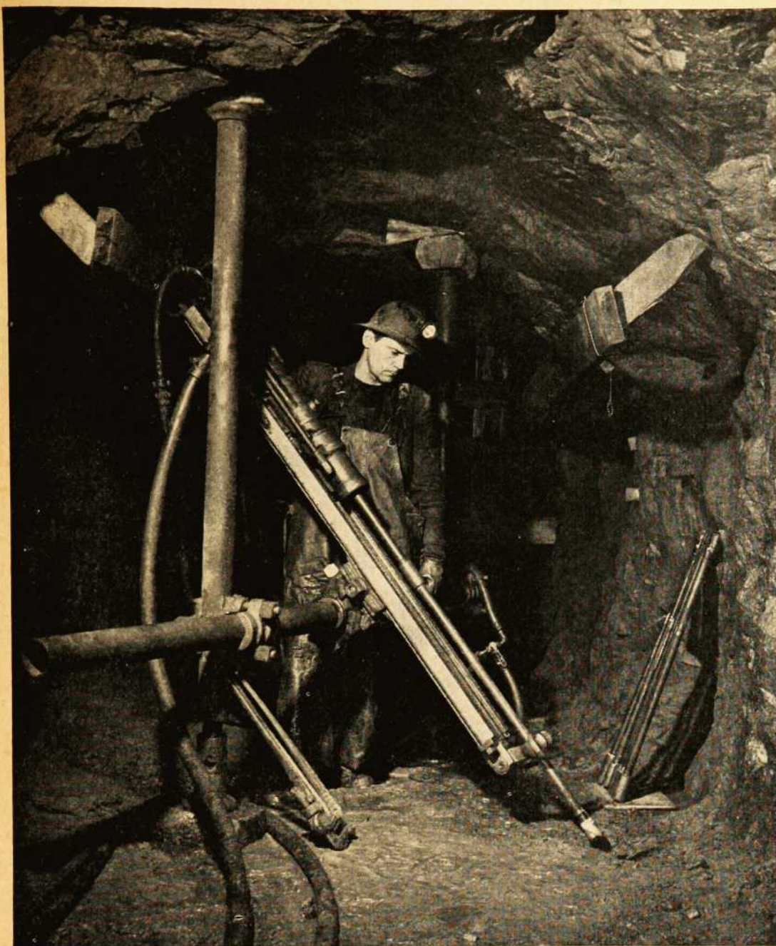
Dans les mines de Murray, à 1,350 pieds sous terre, un mineur utilise une perceuse pneumatique ultra-moderne pour l'extraction du minéral.
