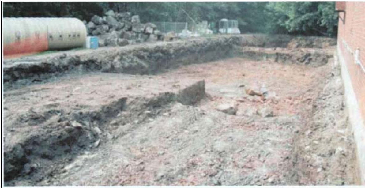
Figure 20. Photographie montrant l'épaisseur de remblais dans la zone Sud-Ouest de la propriété Irving. Cette excavation a été comblée par un remblai non contaminé qui montre actuellement une très faible conductivité électrique.
