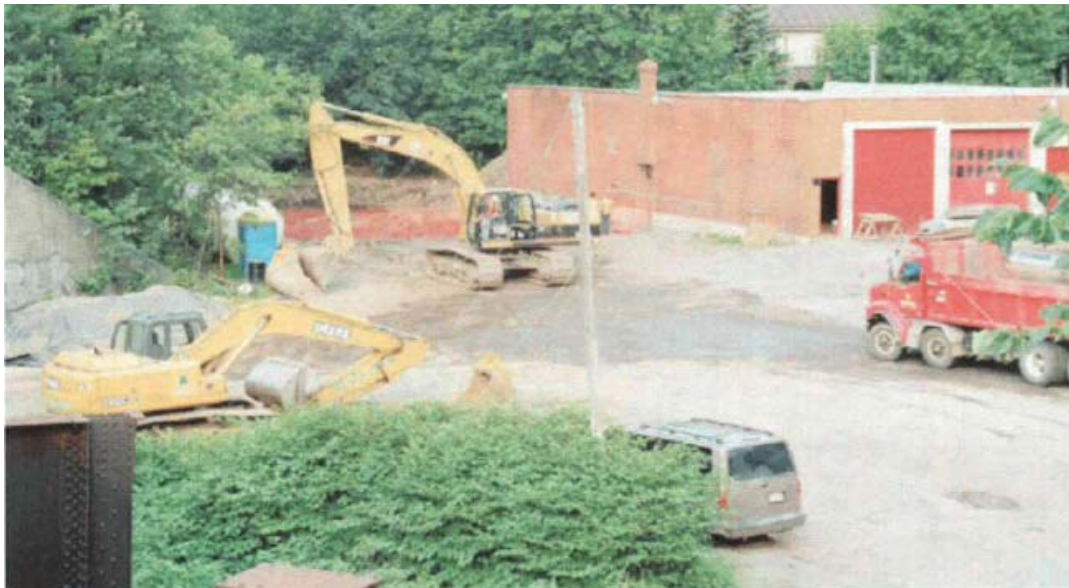
Figure 4. Photographie montrant le bâtiment de la compagnie Irving avant sa démolition en 2006. La position du bâtiment est indiquée sur la figure 3. Photographie tirée du rapport de Slater et Chrétien (2006).
