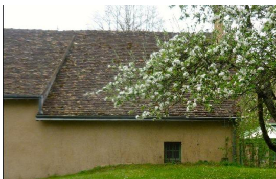
L'arrière de la maison : par la petite fenêtre que l'on aperçoit arrivait l'eau de la rivière qui tombait sur la roue en bois qui activait la roue intérieure
