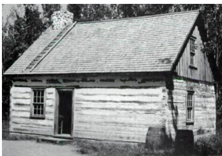
Maison canadienne. Structure massive de pièce sur pièce assemblée en queue d'aronde {photo : Georges-P. Léonidoff}
