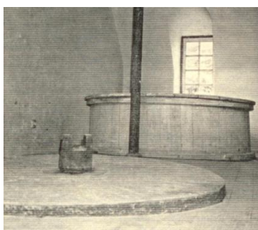
Meules tournante et gisante du moulin {photo Aimé Gagné 1986}
