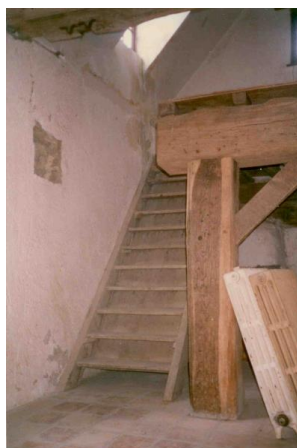
Escalier de meunier {photos : Aimé Gagné 1985}
