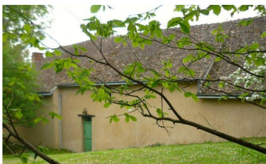
L'arrière de la maison : la porte existait déjà et donnait sur un cagibi qui servait de laiterie {photo : Janine Le Gall}
