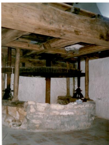
Puits de pierre contenant le mécanisme primaire du moulin 2- Grande roue située sur l'axe central émergeant du puits {photo droite Aimé Gagné 1986, photo gauche Nina Kveseladse 2013}
