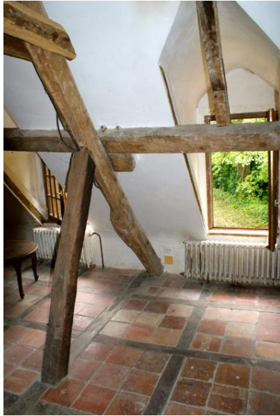
Tomette : carreau ancien recouvrant le sol servant le sol du moulin {photo : Nina Kveseladse 2013}
