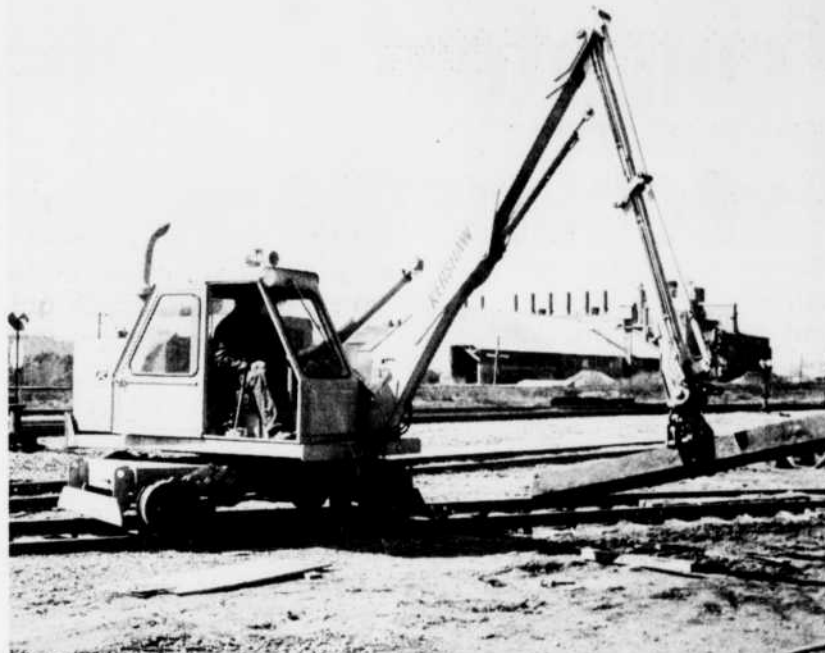
UNE GRUE A DORMANTS , d'acquisition récente, facilite les conditions de travail de ceux qui s'occupent de l'entretien de la voie du Roberval-Saguenay. M. Lucien Milliard en est ici l'opérateur.
