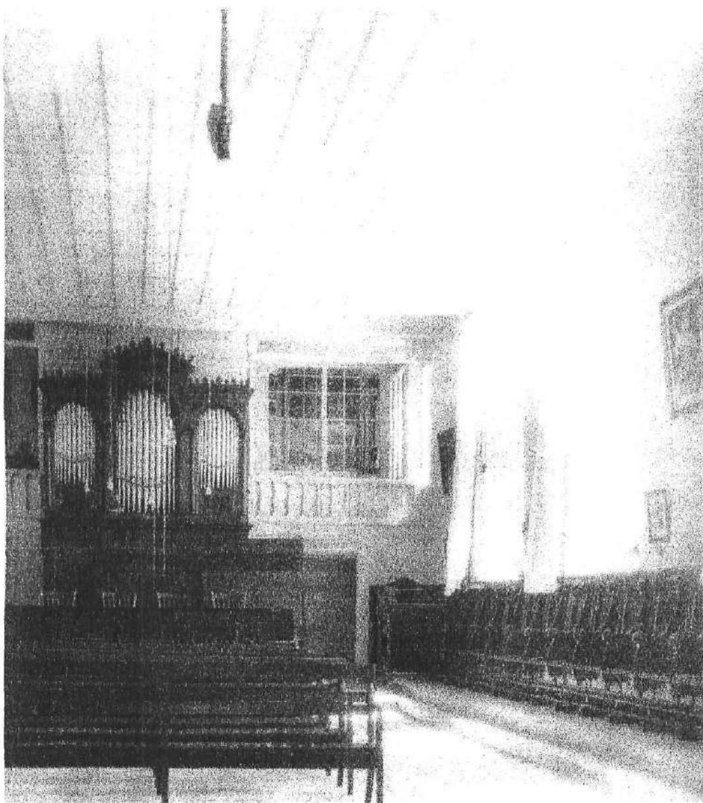
Figure 12 : Vue de l'arrière-chœur des religieuses avant sa réfection en 1929
